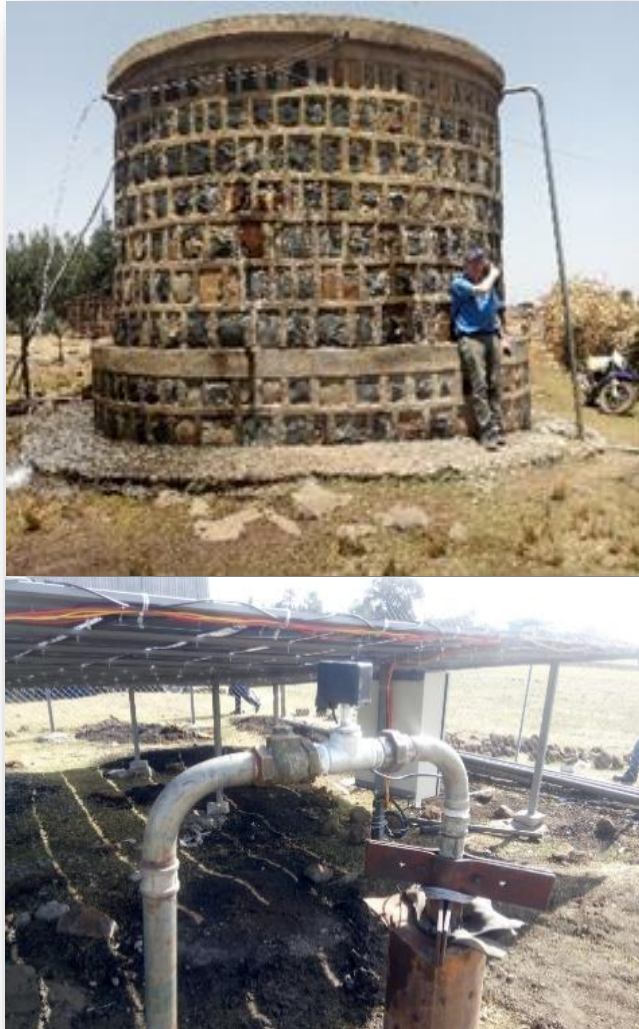
Réservoir maçonné du village de Metera et système de pompage solaire
