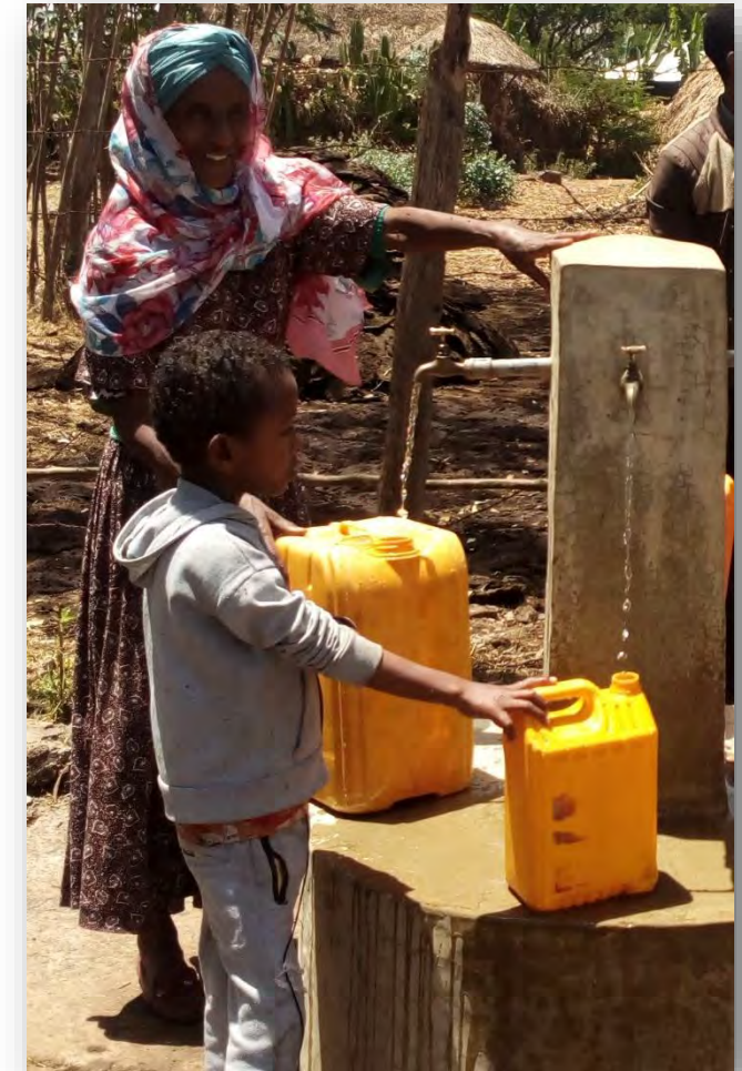
Point de distribution d'eau potable dans le village de Metera
